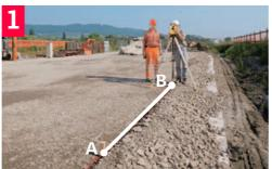
Mettre l'instrument en place et le niveler au-dessus du point B.
